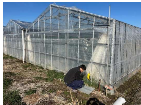
図 3 ハウス外観と調査の様子
