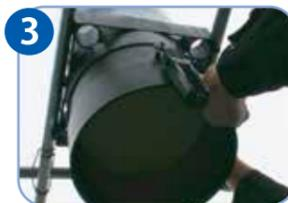
補助パイプを添えて空動扇を挟み込むように固定します。
